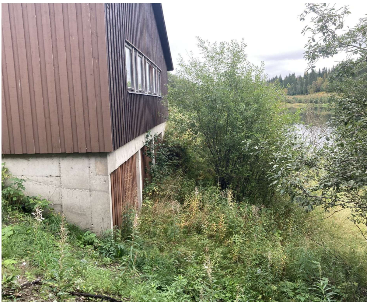
Figur 10: Kantsone ved Saltfjellveien 12. Foto: Helge Lynghaug/Asplan Viak (2023)
