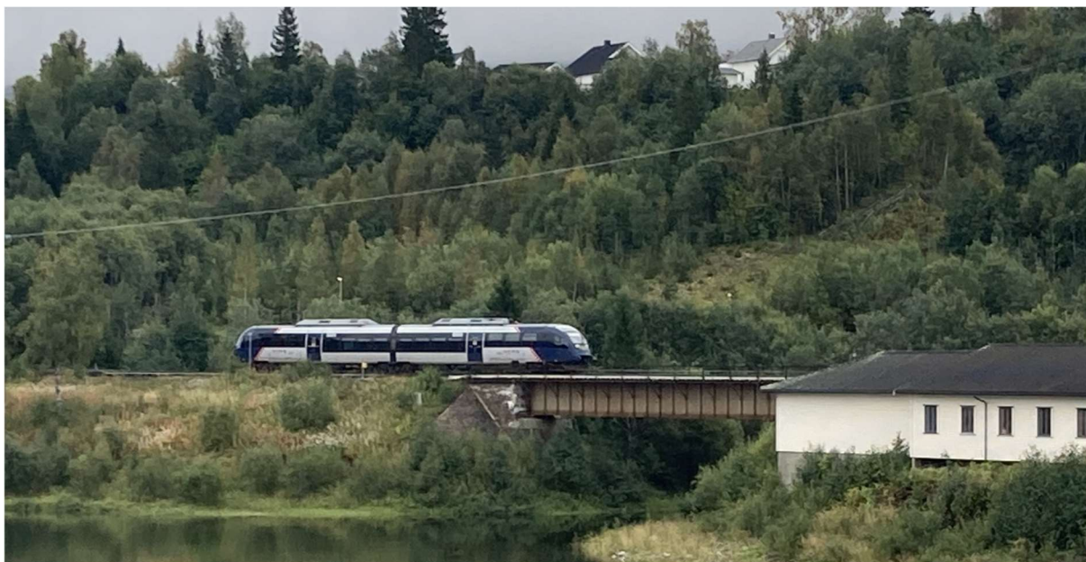
Figur 18: Nordlandsbanen går på sørsiden av Ranelva. Foto: Helge Lynghaug/Asplan Viak (2023)
