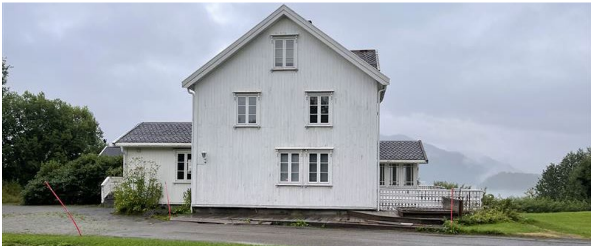
Figur 44. Eksisterende enebolig med saltak, tilbygg og arker.
