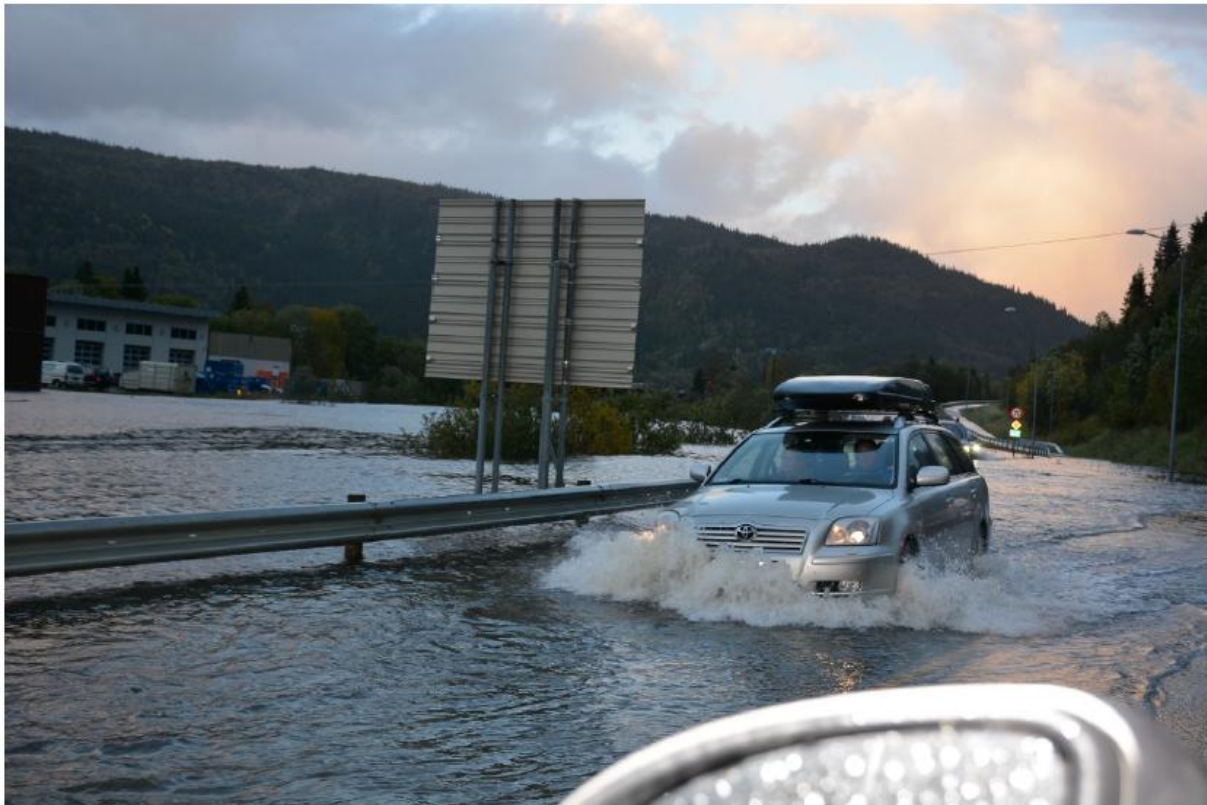
Figur 2: Tverråga renner over veien ved brua langs E12. Bildet er hentet fra Rana Blad, og ble publisert 21.09.2020 kl. 21:21 (RanaBlad, 2020).
