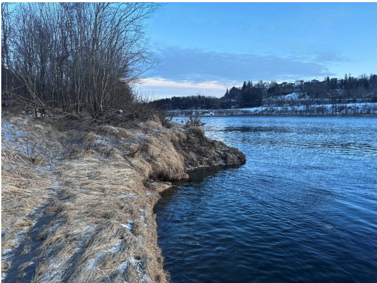
Figur 10: Eksempel på erosjon observert ved planområdet. Erosjon har blottlagt et lite område med lett eroderbare masser.
