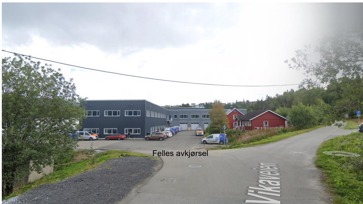
Figur 7 Plussbygget og Vikaveien 41 og 43 sett fra felles avkjørsel. Fortau under opparbeiding. Kilde: Google street view.
