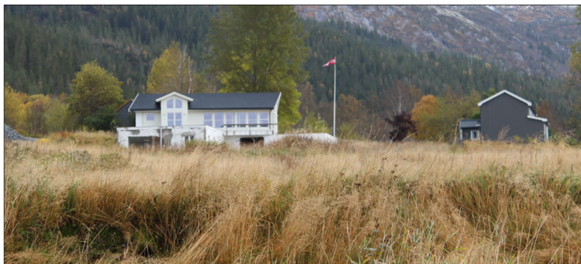
Figur 4. Viser eksisterende bygg (BF23 i fig. 3) til venstre og våningshus til høyre. (Asplan Viak, 2024)
