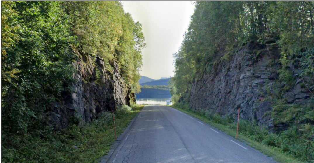
Figur 9. Viser bergskjæring ved Flostrandveien. Beliggenhet vist som [1] i fig.8. (Google, 2024)
