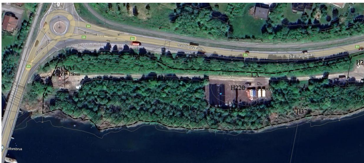
Figur 23 Riggområde i forbindelse med kommunens arbeid
