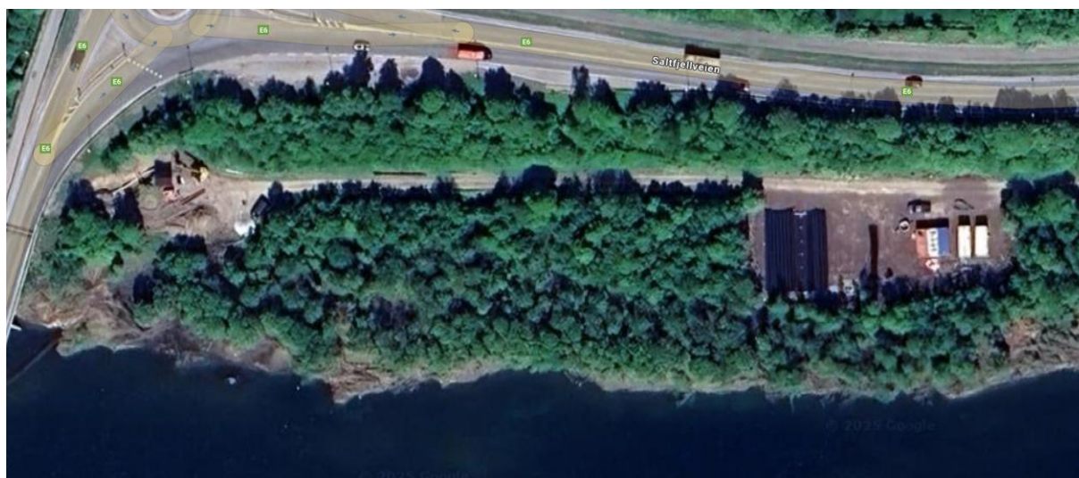
Figur 6 VA-anlegg og rigg-område
