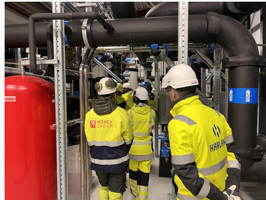
Pilotfabrikken, leverandører på befaring
