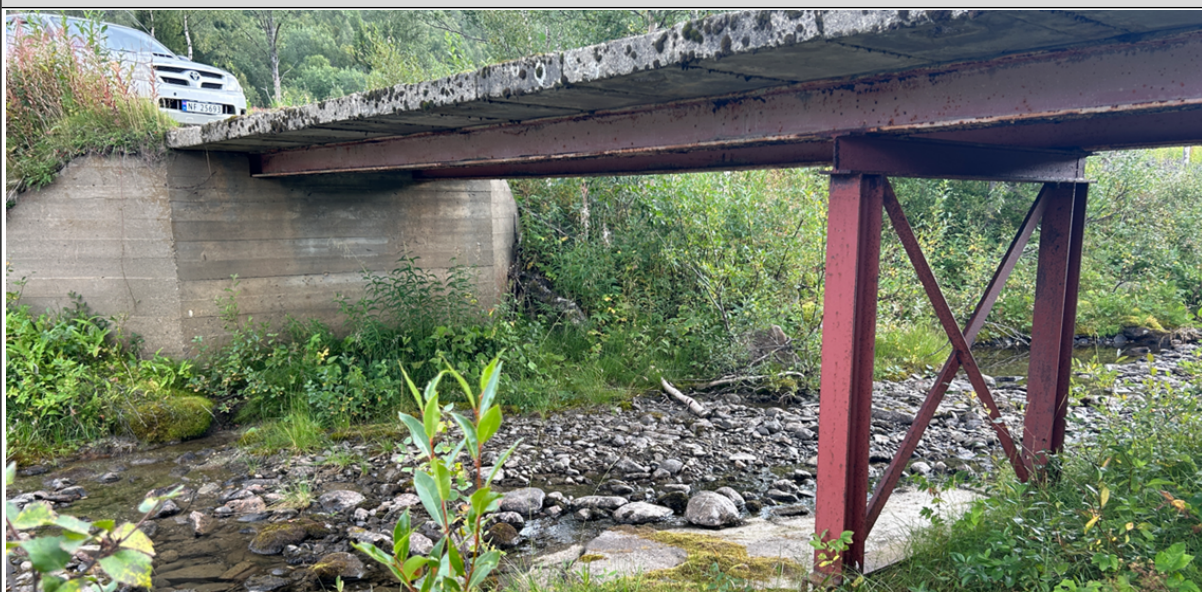
Figur 4-4 Bilder av bruer og kulvert i analyseområdet (foto tatt i august 2023).
