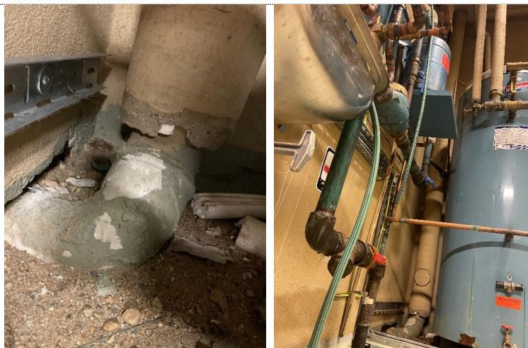
Bilde B6: P6 Isolasjon rundt rør. Plan U VV-rom.
