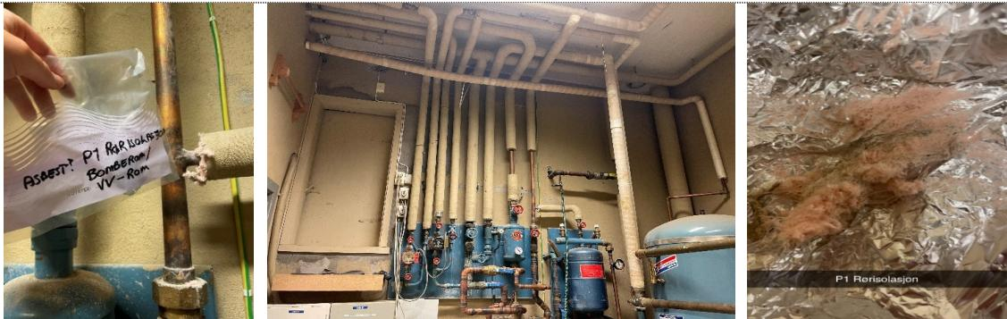
Bilde B2: P2 Rørisolasjon. Plan U VV-rom.
