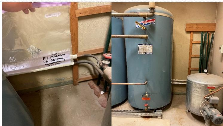
Bilde B5: P5 Grønn maling over påstøp på avløpsrør. Plan U VV-rom.
