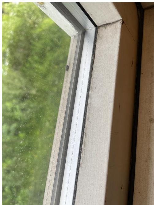
Bilde B25: Isolerglass fra 2002 med innhold av ftalater. Plan 2 202 Bibliotek
