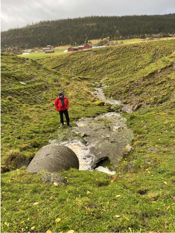
Bilde 1: Utløp fra støttefylling: Bekken er lagt i rør under fylkesveien og gjennom en støttefylling.
