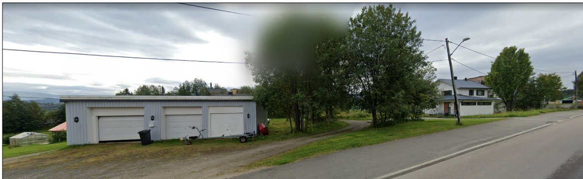
Figur 3. Viser Båsmoveien 41 (høyre) og Båsmoveien 37 (Garasje til venstre) sett fra nord mot sørøst. (Google, 2023)
