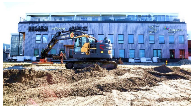
Arbeid ved Momentparken og sjøfronten
