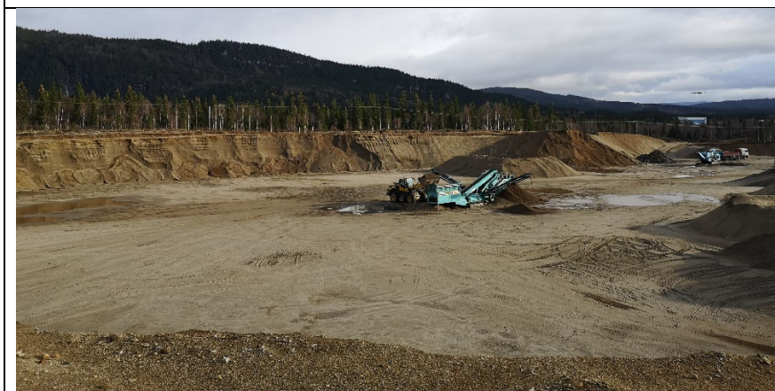
Figur 4-4: På nordvestlig side av grustaket. Grustaket er planlagt utvidet inn i bildet, i retning strømlødingen.
