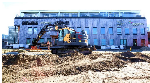
Arbeid ved Momentparken og sjøfronten
