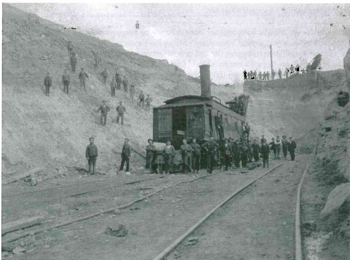
Fra utgraving av Vikaskjæringa ca 1902-03
