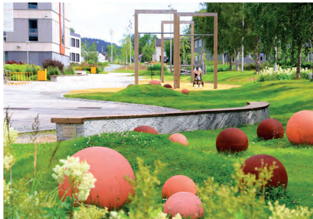
Nordlandsparken er et godt eksempel på et byrom som har lokal overvannshåndtering med visuelle kvaliteter. Overvann kan infiltreres i regnbed og vegetasjonsfelter, forsinkes på grønne tak, i åpne renner, kanaler, bekker og dammer.
