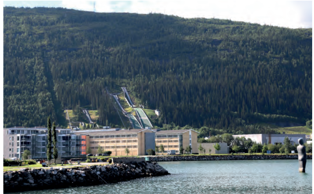
Mobekkleira ved Sjøfronten.
