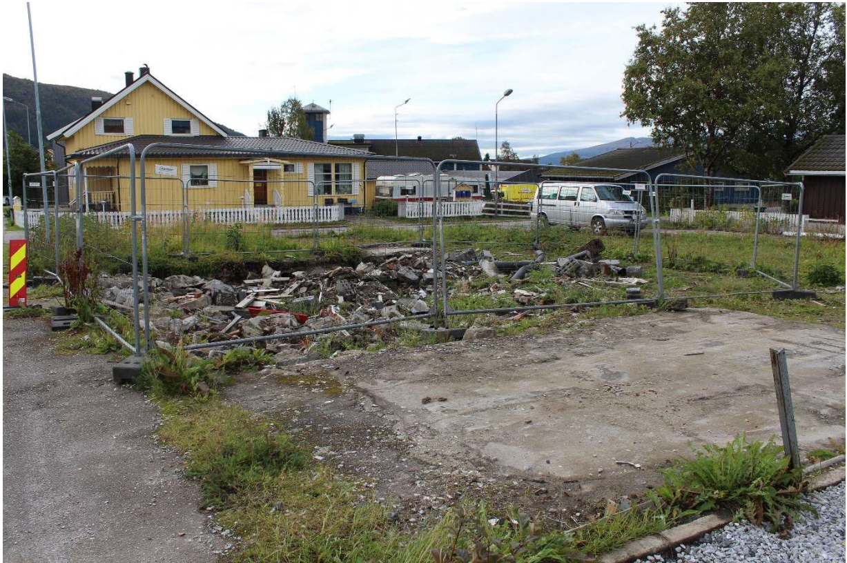
Figur 5: Nordlandsveien 41 etter rivning. Bilde tatt fra Nordlandsveien.
